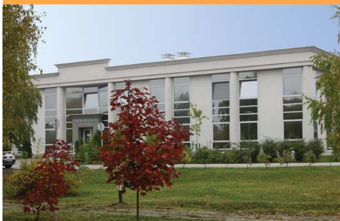
Az Onkoradiológiai Centrum épülete emeletráépítést kap – ahogyan eredetileg tervezték
